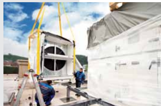
Installation sur site d'une X-CUBE pour montage extérieur
