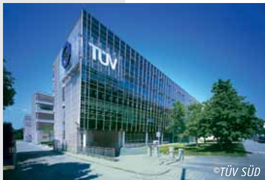
Les centrales de traitement d'air TROX sont régulièrement contrôlées (par l'organisme de contrôle indépendant TÜV SÜD en Allemagne, par exemple).
