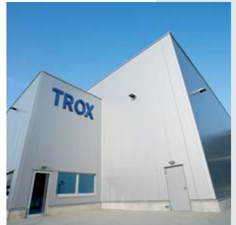
Usine de production TROX à Anholt, en Allemagne
